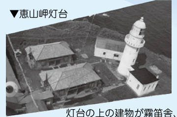
灯台の上の建物が霧笛舎、左側の2つの建物が退息所
